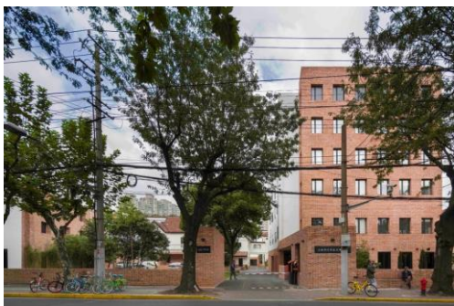
上海愚园路改造
